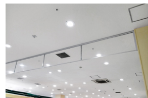
透明性に優れたガラス繊維強化樹脂シート「ユークリアーシート」 使用例：防煙垂壁
