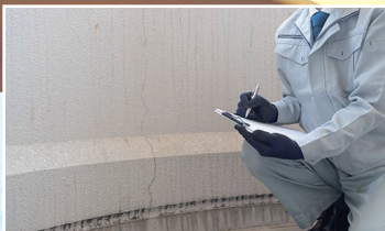
構造物の保護・補強
