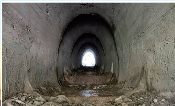
施工が困難な閉鎖空間・物品
