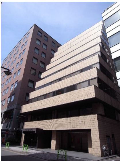
移転先: 共同ビル
